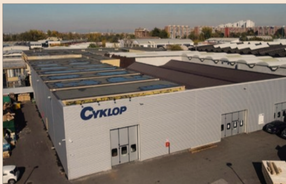
Panoramica dello stabilimento
